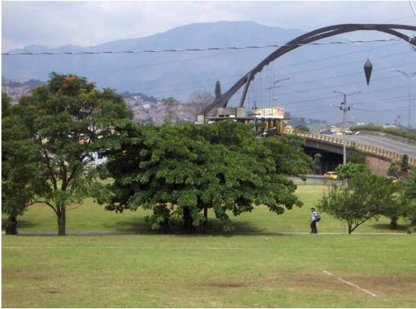
Barrera contra el ruido en el intercambio vial
