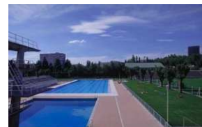
Complejo deportivo zona Sur
