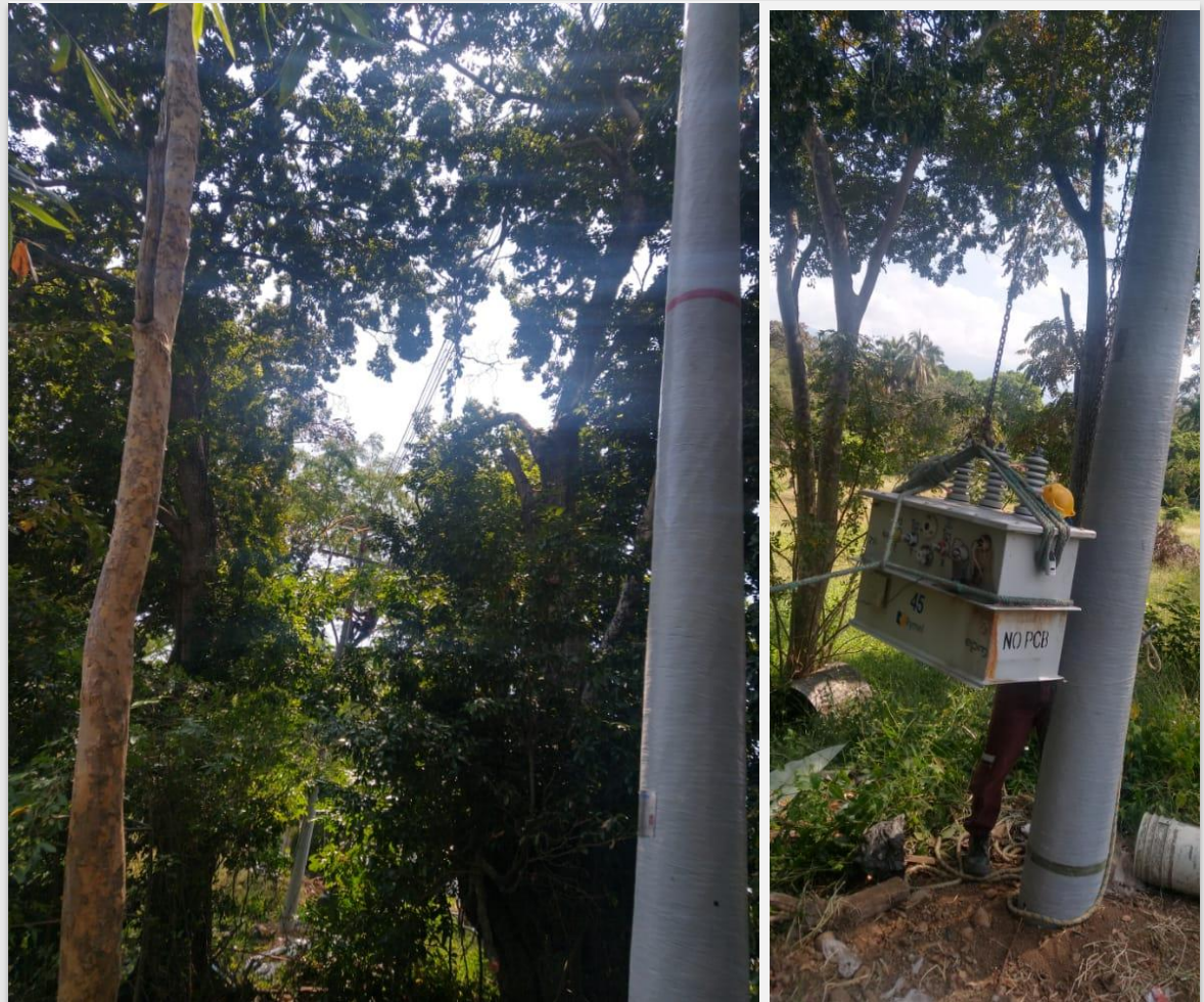
1.Instalación De poste de fibra e instalación de transformador- C.A Cotové
