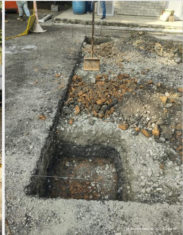
2.. Excavación manual para fundaciones
