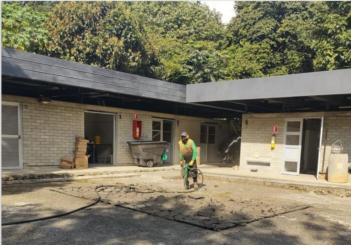
1. Demolición de carpeta asfáltica – Áreas de Compostaje Campus Robledo
