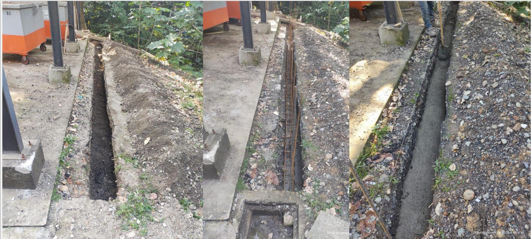
1.Excavación de viga de fundación – Cajas estacionarias Robledo
