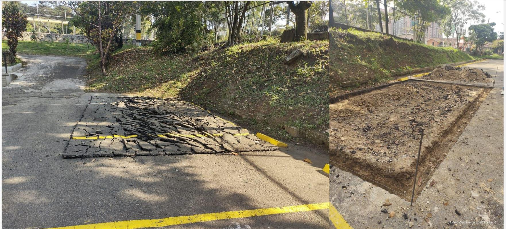
1. Demolición y retiro de la carpeta asfáltica bloque M1 – Campus Robledo
