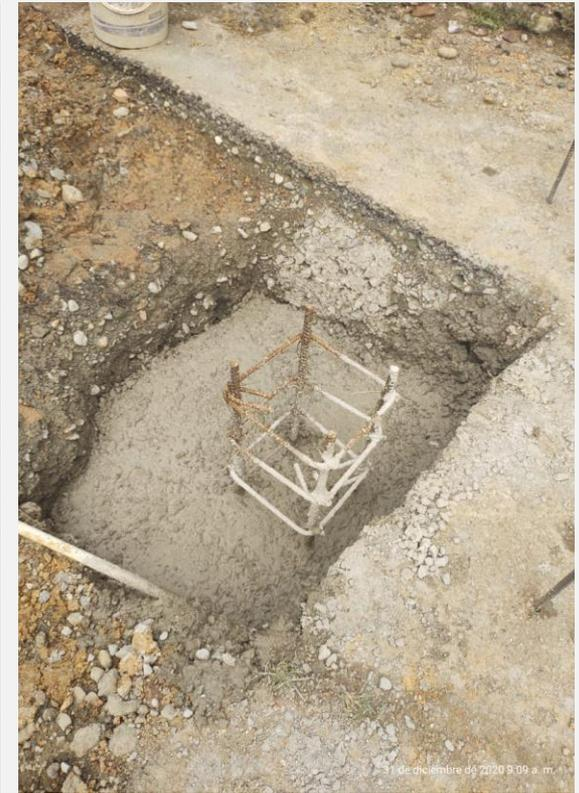
2.. Excavación manual para fundaciones
