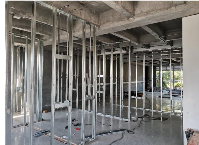
Construcción de cerramientos
